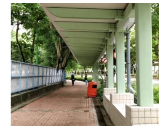
在北區保平路設置的有蓋行人通道
